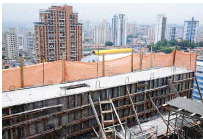
A construção das paredes (alvenaria) externa está praticamente concluída. A estrutura de concreto armado está em conclusão na cobertura. Também está em fase final a estrutura do reservatório de água, na parte superior do edifício, tendo sido realizadas as concretagens, restando a desforma e remoção do escoramento metálico.
