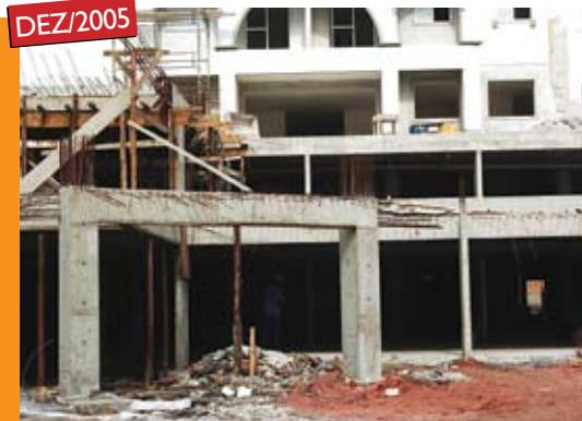
comprometer a qualidade. Hoje, os blocos de fundação e o piso de concreto estão totalmente concluídos nos Blocos A e B. Foi iniciada a montagem da forma dos pilares do subsolo do Bloco B.
